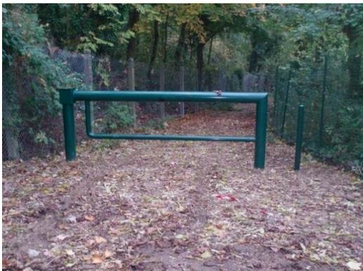
Type de barrière installé par le SyAGE pour limiter l'accès des véhicules aux entrées/.sorties de chemin
