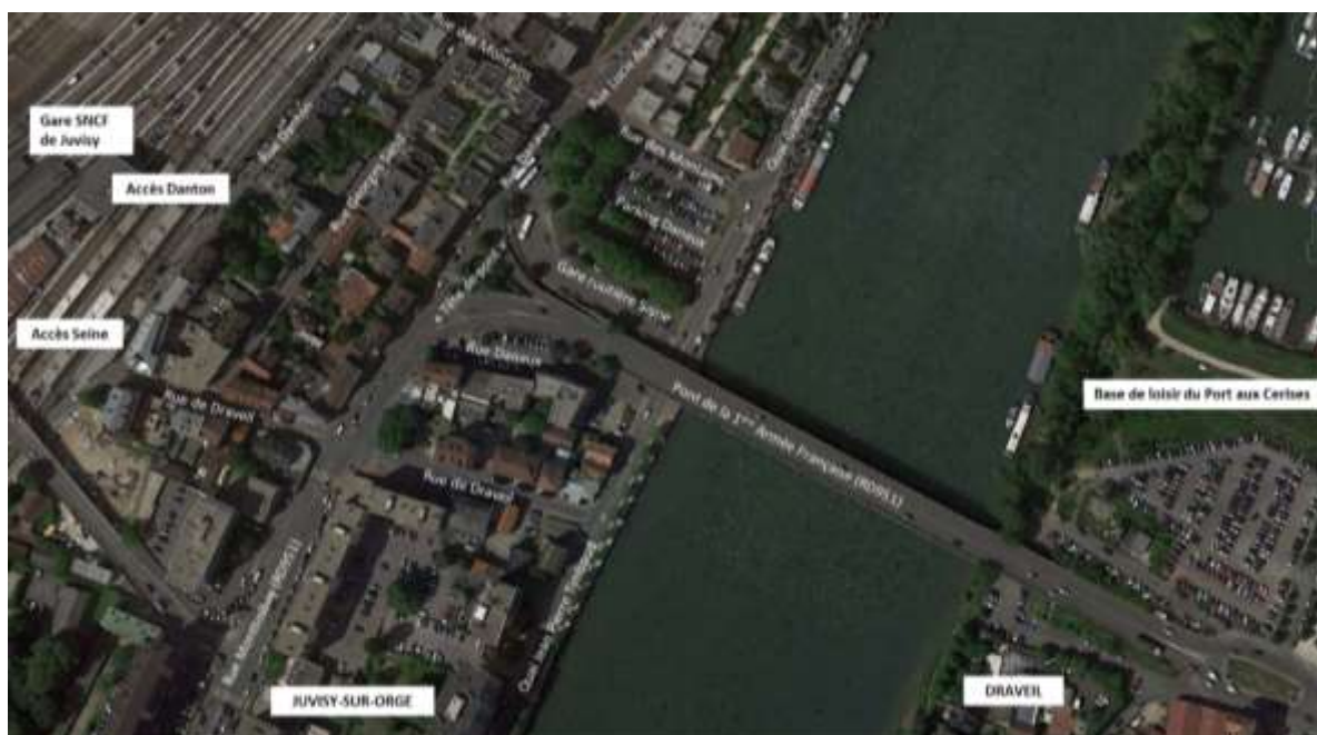
Figure 5 – Vue d'ensemble de la gare routière Seine et du parking Danaux
