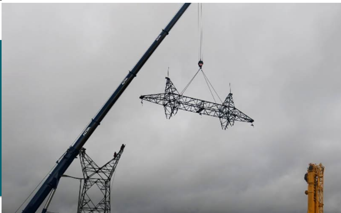
Opération de dépose des Lignes à Haute Tension, rue Jules Vallès à Choisy le Roi le 9 octobre 2019
