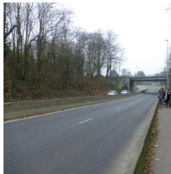
absence d'espace dédié au piéton le long de la RD
