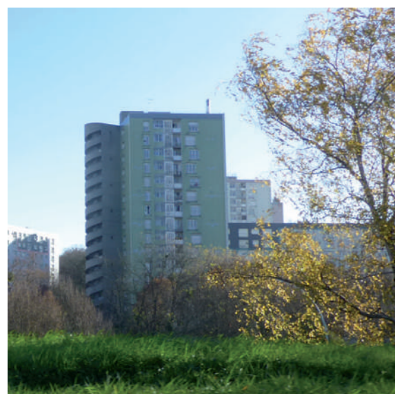
Vue depuis la départementale D25
