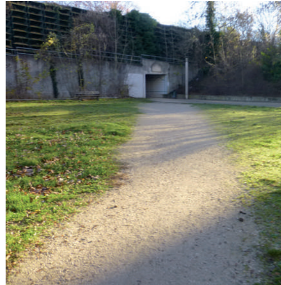
Entrée du tunnel
