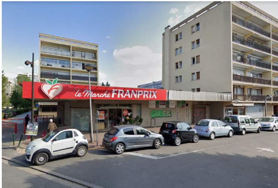
Pôle commercial de quartier à proximité du périmètre projet (Google Maps)
