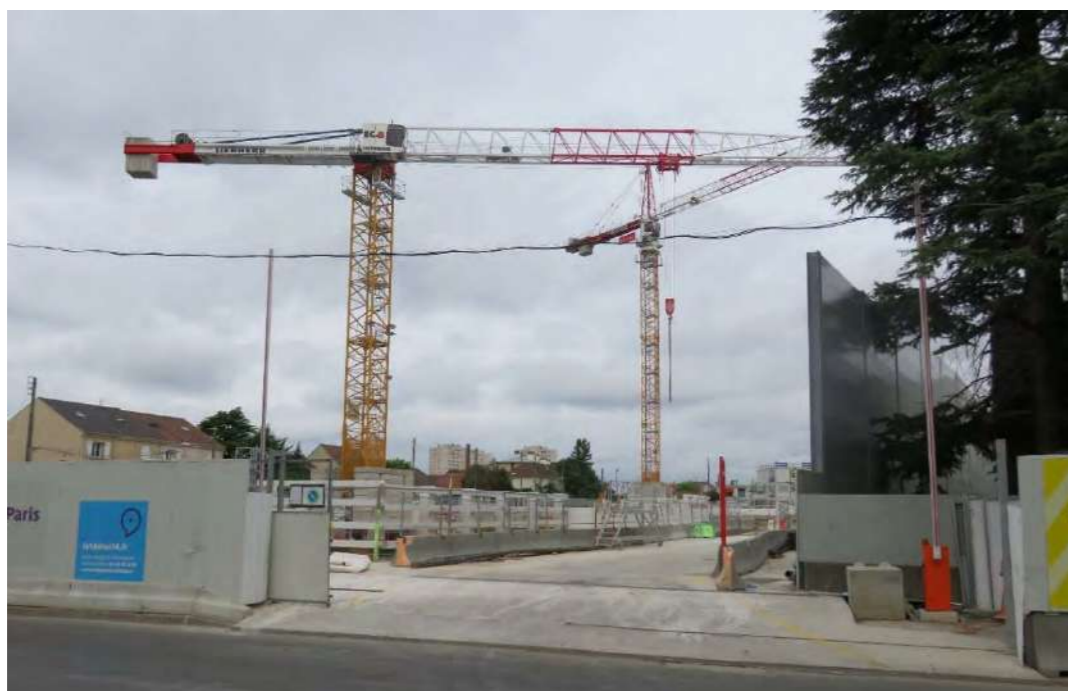
Zone de travaux pour la gare « Trois Communes » du Grand Paris Express – Source : EVEN Conseil
