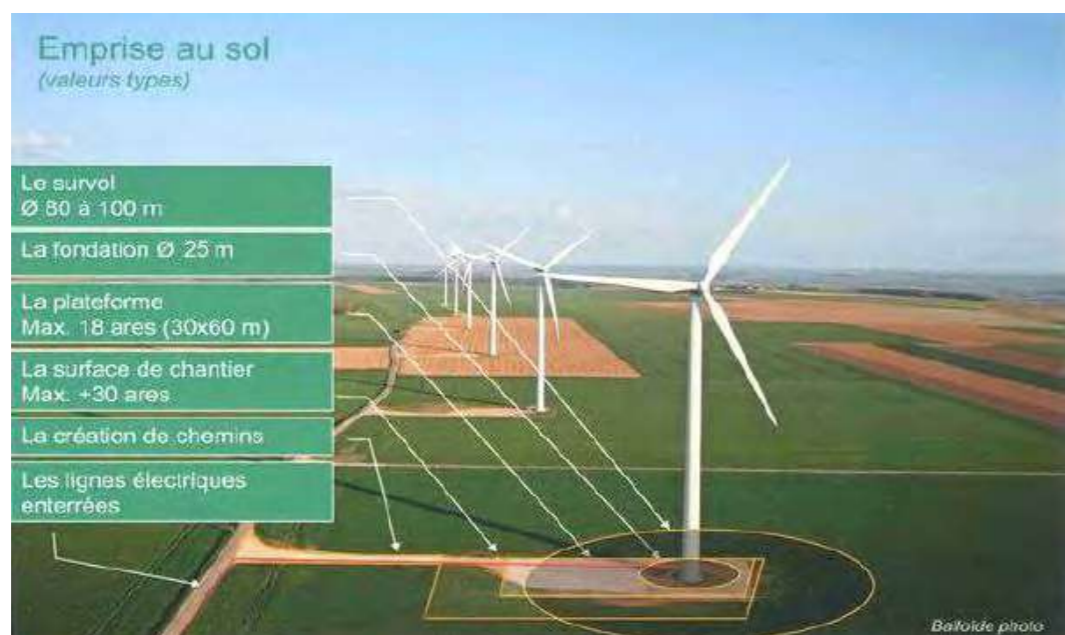
Description de l'emprise au sol d'une éolienne de 2,5 MW – Source : Theolia France
