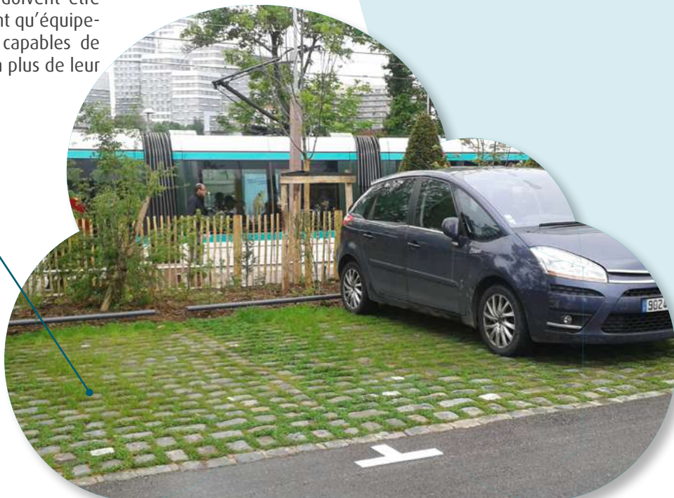
Parking infiltrant évitant l'imperméabilisation, Fresnes (DRIEE)
