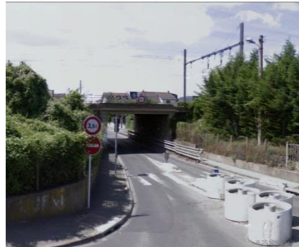
Le tunnel sous les voies ferrées voie de Seine
