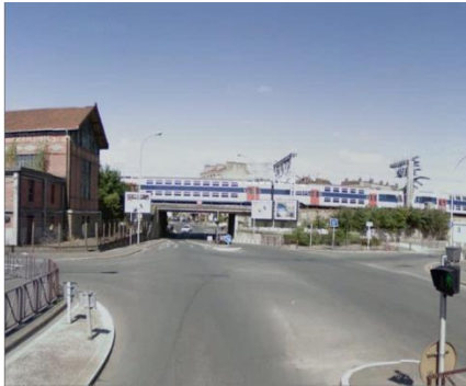
Le tunnel sous les voies ferrées avenue Le Foll
