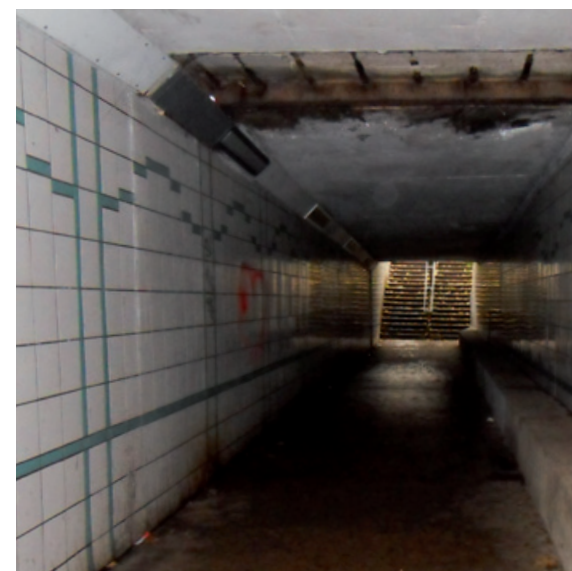
Tunnel piéton vers Grand Val
