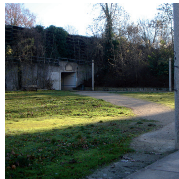
Entrée du tunnel piéton vers Grand Val
