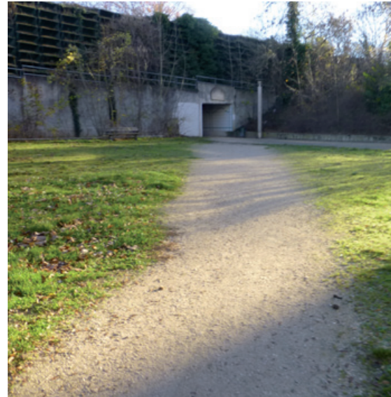
Entrée du tunnel
