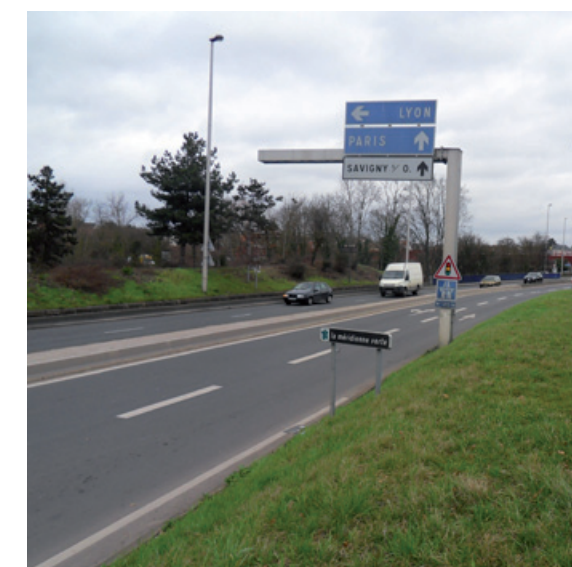
Pas de continuité piétonne sur la RD
