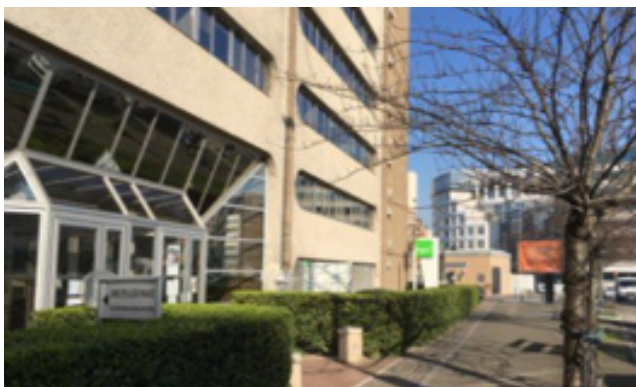
Source : Est Ensemble
