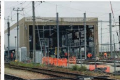
Rénovation du Technicentre de VSG
